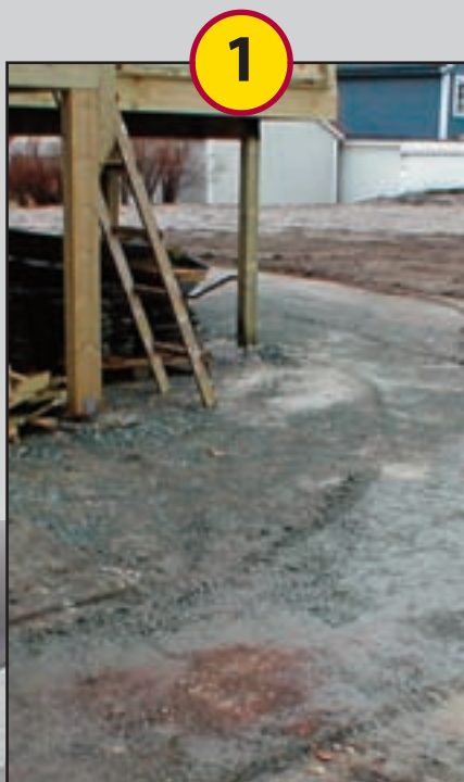
Sørg for et avrettet og drenerende underlag.
