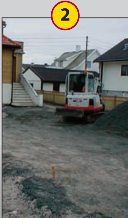
Legg ut 3-5 cm støpesand eller fingrus, max 8 mm. Bruk gjerne lirer til avrettingen.
